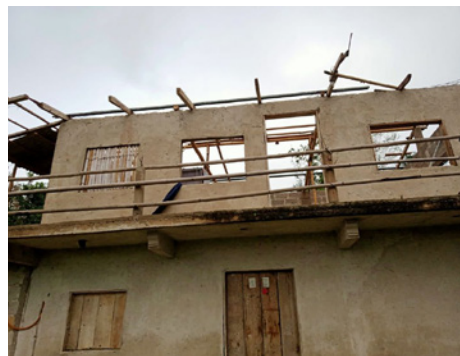
Una casa despojada de su lámina en la Sierra Norte de Puebla, México.
